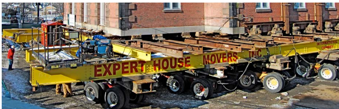
Рисунок 1. Перенос здания на колесных тележках с гидравлическим приводом
