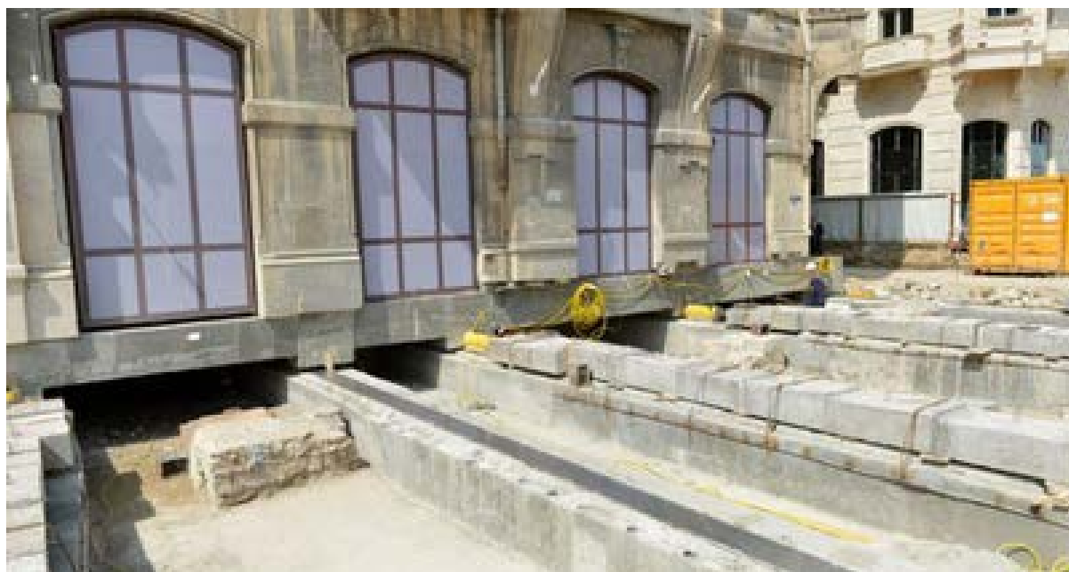
Рисунок 2. Перенос исторического здания в Баку (2013 год)
